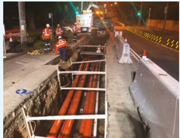
Νυχτερινές εργασίες διάνοιξης τάφρων στην Old Canterbury Road, Ashfield
