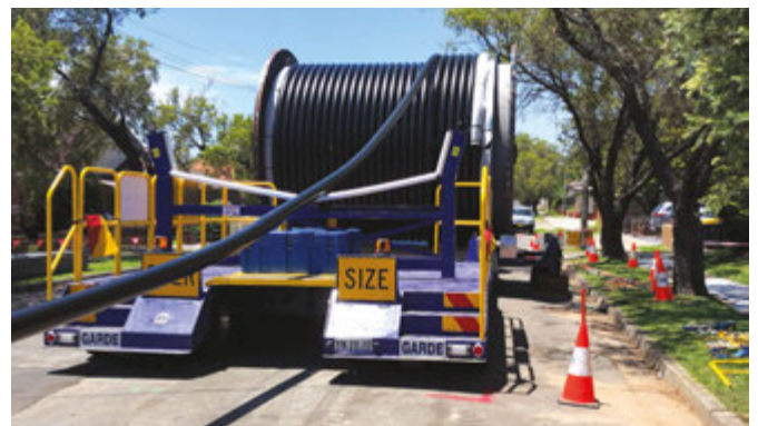
电缆从重型卡车的电缆卷筒中被拉入铺埋于沟槽内的管道
