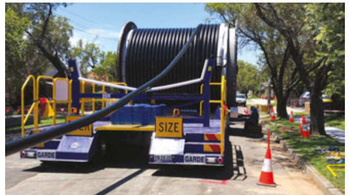
電纜從重型卡車的電纜捲筒中被拉入鋪埋於溝槽內的管道
