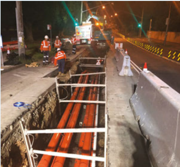
أعمال حفر الخنادق الليلية على طريق Old Canterbury Road, Ashfield
