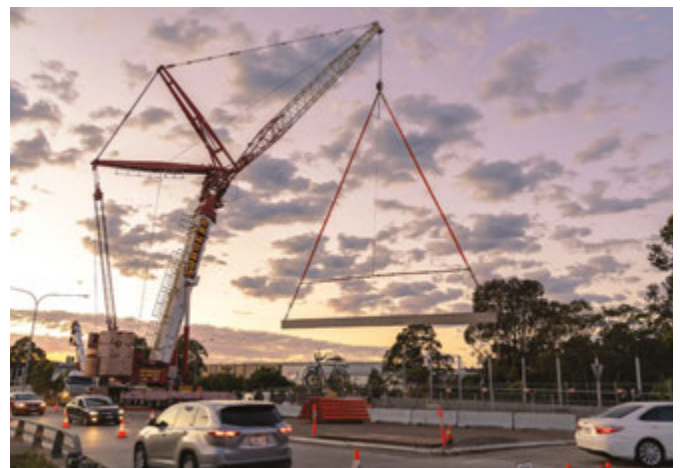
10月份长周末期间Muir路电缆桥架施工
